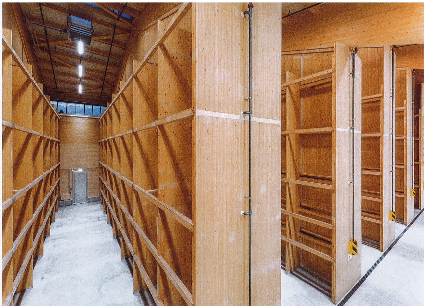
Die neuen Brandschutzvorschriften ermöglichen massgeschneiderte Konzepte, die auf das tatsächliche Risiko abgestimmt sind. Hier das Hochregallager aus Holz der Appenzeller Alpenbitter AG.
